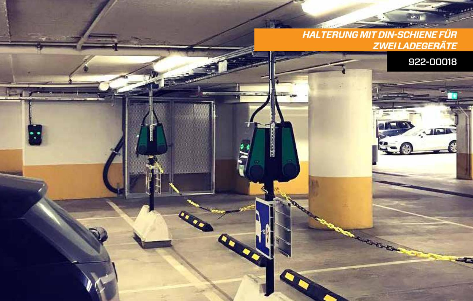
**HALTERUNG MIT DIN-SCHIENE FÜR ZWEI LADEGERÄTE**
